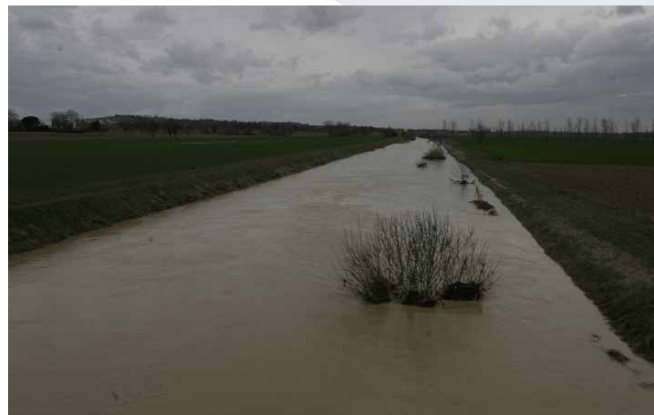
Inondation © Mairie de Pompertuzat
