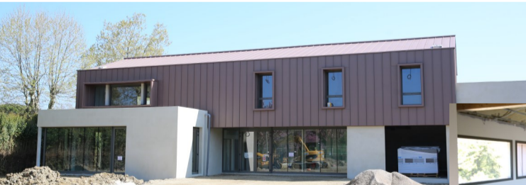
La façade achevée, recouverte de bardage en zinc, la future salle de répétition des orchestres et la rampe d'accès à la salle Garoche.
